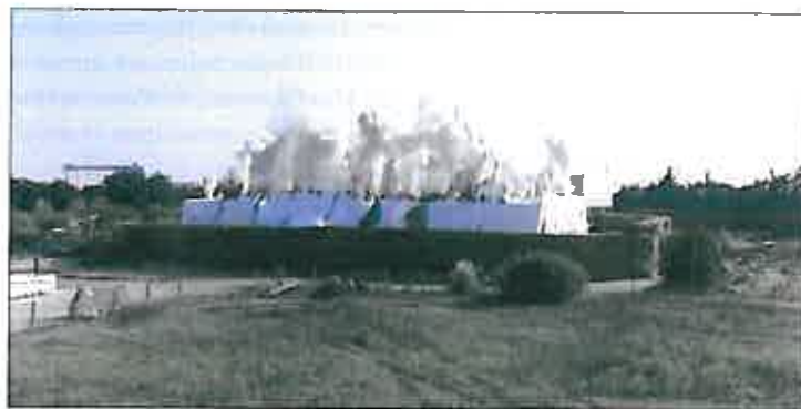
Destruction d'un blockhaus à l'explosif
